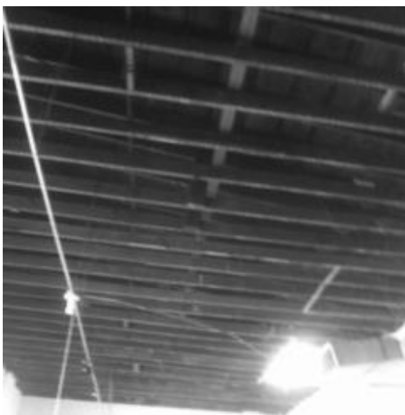
Fig. 6. Techumbre del San Luis Fuente: Tomada por los autores
